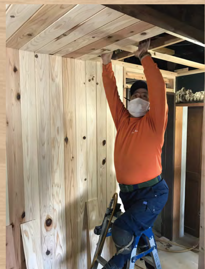
床板・羽目板張り
