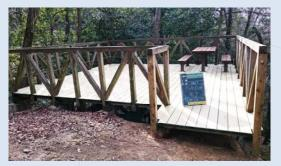
工事内容は、テントサイトのデッキ3ヶ所の張り替えです。長年使い 続けてきて、デッキに穴が空いていたり、根太が腐食していたりで、 新しいデッキ材に替える必要性がありました。
