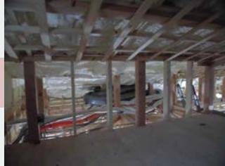
この写真は2階の天井裏です。今回換気設備として24時間稼働して給気と排気を行ってくれる機械(第1種換気設備)を設置しました。熱交換も行ってくれるので、室内を一定の温度で給排気してくれます。
