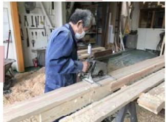
今回の新築には和室もあります。和室の建具枠や押し入れ、窓枠はすべて棟梁の手作りです。材料は桧で写真は鴨居・敷居の溝を彫っているところです。
