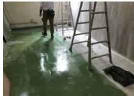
打ったコンクリート壁を弊社職人で表面を綺麗にし、床の割った場所のコンクリートを復旧して形は完成です。
