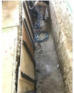
その後、施工範囲の床を割って、土を掘削しました。小さい重機
