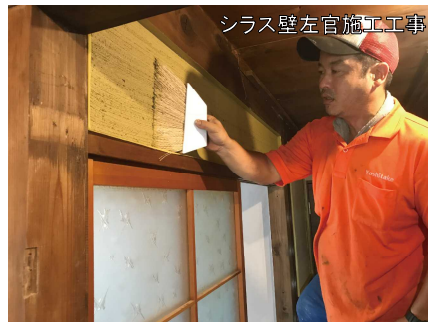
シラス壁左官施工工事
