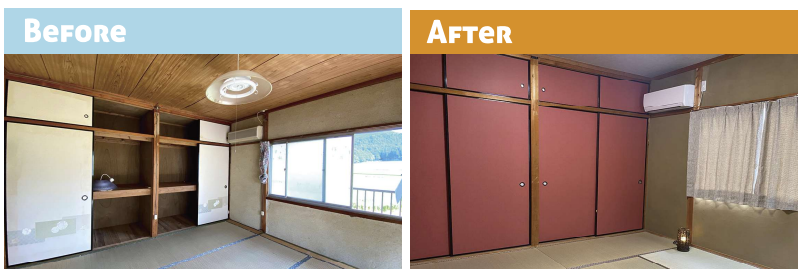
▲管理棟2階 和室
