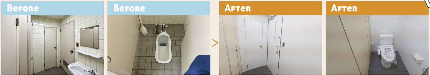
大阪市淀川区にある保育園の、事務室トイレを改修しました。既存のトイレブース及び衛生器具を撤去した後、壁は既存タイルの上に化粧パネルを貼って仕上げ、床は既存タイルの上にタイルを重ねて仕上げました。
