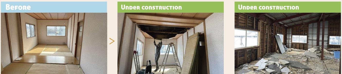
事業再構築補助金を使つての改修工事が着工しました。内部工事は、2階部分をフルリフォームし、1階の各部屋の用途変更、外部工事は玄関サッシの取替、外壁1面を金属サイディングによるカバー工法残り3面を塗装する工事です。お客様の営業を妨げないようにしながらの工事になりますので、細心の注意を払いながら、作業を進めていきます。
