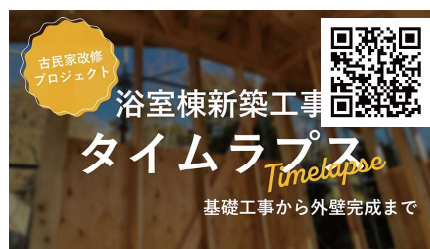
△【タイムラプス】古民家の横に浴室棟を新築!工事の様子をご紹介します
